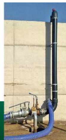
Be- und Entnahme über die Behälterwand
