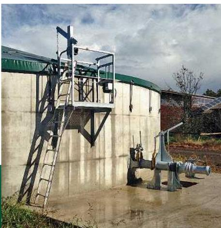
Be- und Entnahme direkt durch die Behälterwand
